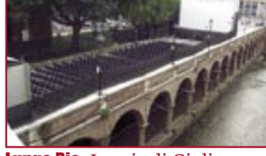
Lungo Rio, Loggia di Giulio Romano
